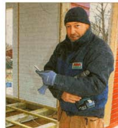
Zimmermann Kai Beuck von der Firma Jorkisch trotz der Kälte. In diesen Tagen soll alles fertig sein.
